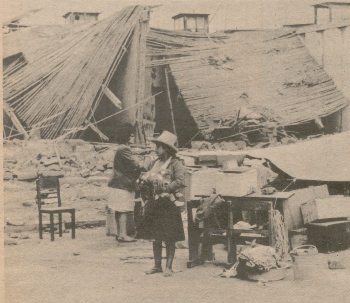
CHIMBOTE (Perú).— La mayor parte de Chimbote quedó destruida a causa del reciente temblor de tierra que sacudió al país. La foto capta los restos de lo que fué una escuela.
