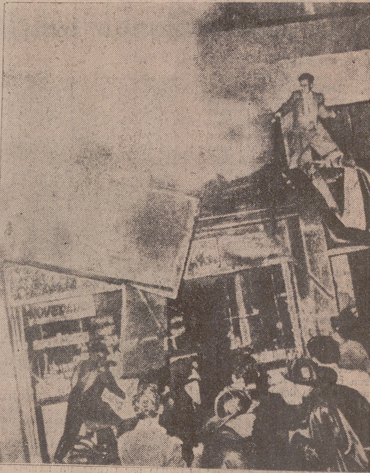
Un aspecto del escalofriante incendio ocurrido en la escuela de Santa Maria de los Angeles, en Chicago.
