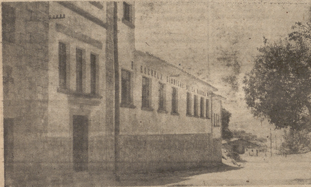
Fachada principal de la Escuela Sindical de la Madera. (Foto Delgado.)
