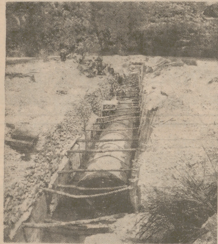
Una vista de los trabajos en la galería de aguas subterráneas.
