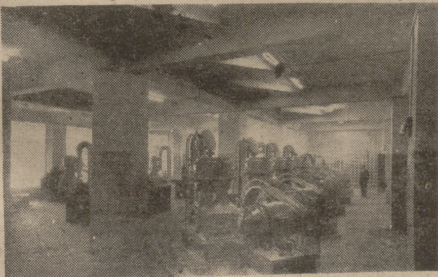
Vista parcial de la sala de máquinas
