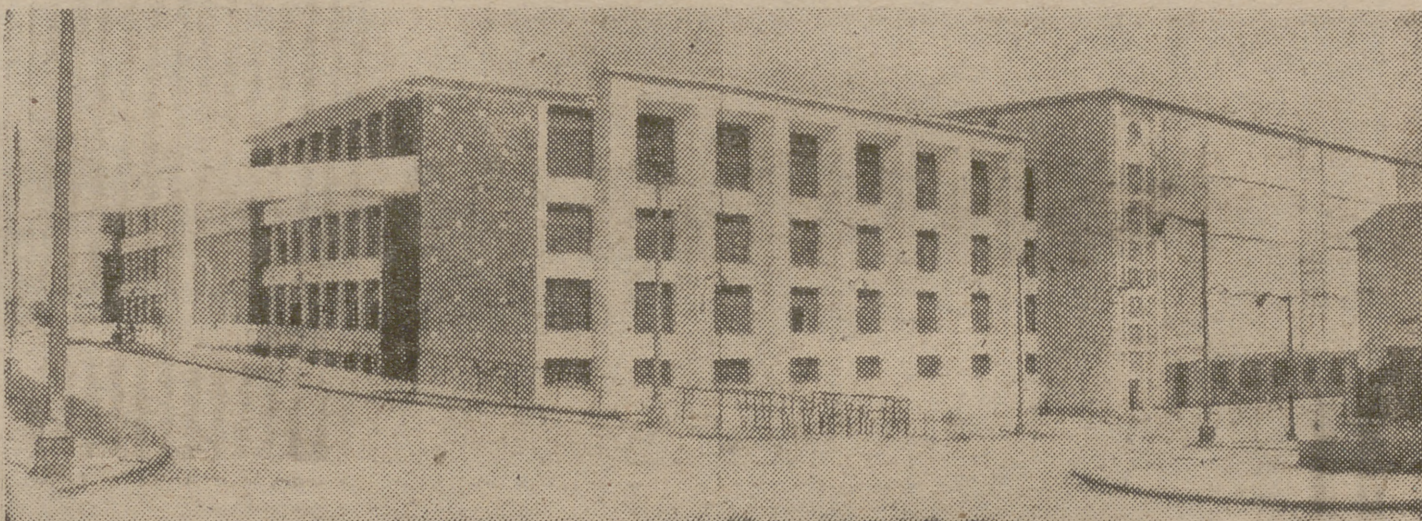
Edificio en el cual se hallan instalados todos los servicios de sacrificio de las reses
