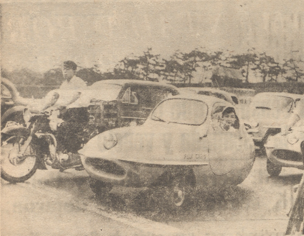
La industria automovilística japonesa, no solamente recuperada, sino en trance de dar la batalla a sus competidores alemanes, ingleses, norteamericanos e italianos, acaba de lanzar su primer coche popular. El "Fuji Cabin" tiene un motor de cinco caballos y puede alcanzar una velocidad de 80 kilómetros por hora. (Foto Keystone-Nemes.)
