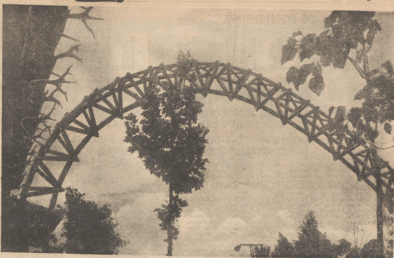
Artístico contraluz del arco de madera, en celosía, que enlaza el pabellón de Montes con el Parque Forestal.
