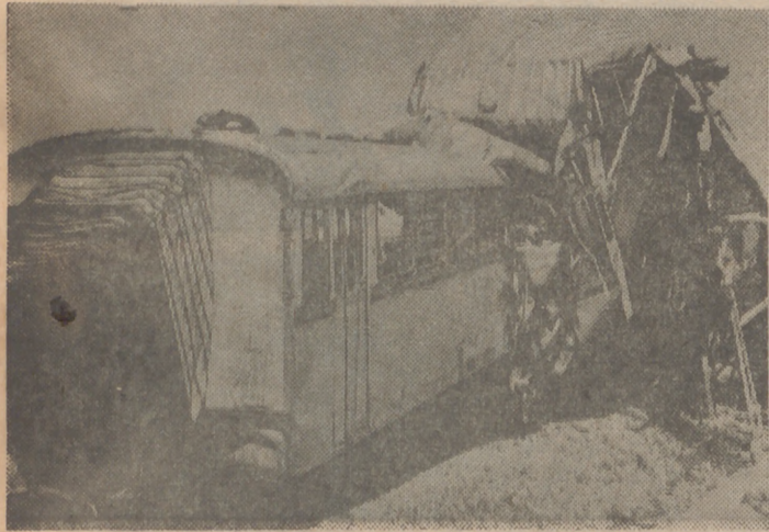
El estado en que quedó uno de los vagones del ferrobús, da idea de la violencia del terrible choque. Fuerzas de la Guardia Civil, helicópteros de la base de Rota y numerosos voluntarios, además del personal especializado de la Renfe, tomaron parte en las tareas de salvamento y traslado de heridos a los hospitales
