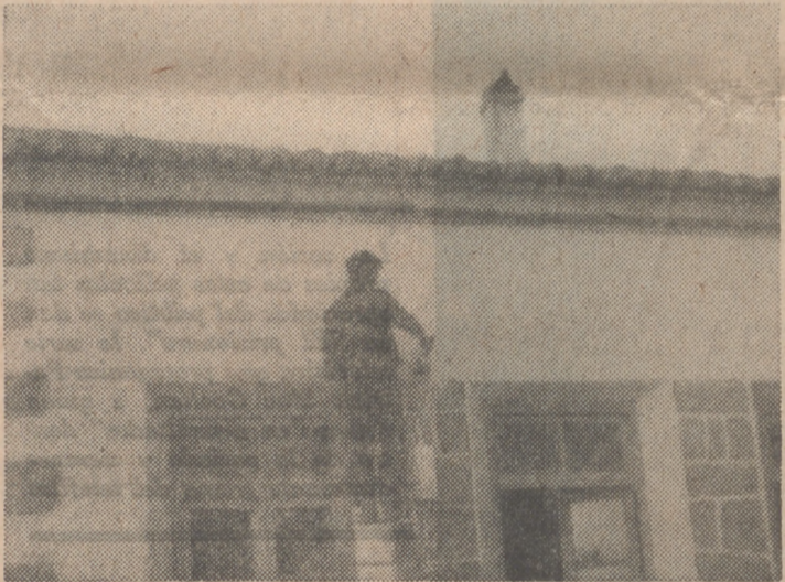
Hubo un revoco general. Las fachadas de las escuelas fueron pintadas de nuevo. Y los columpios y bancos del jardín infantil
