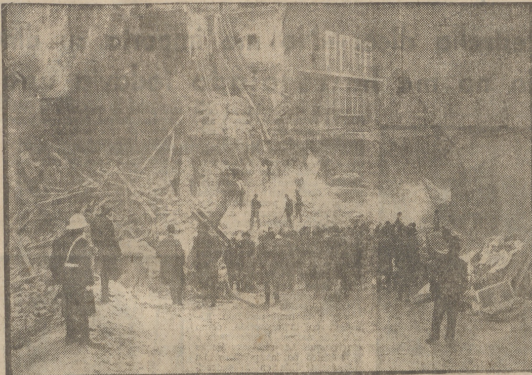
Este es el estado en que ha quedado la casa de seis plantas que se ha derrumbado en Madrid, y que, afortunadamente, no ha producido víctimas
