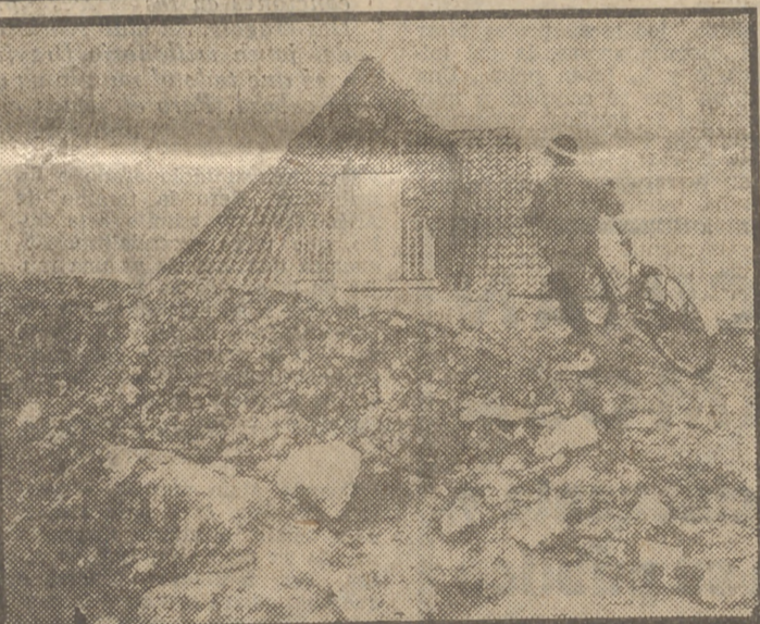
Con la casa enterrada
