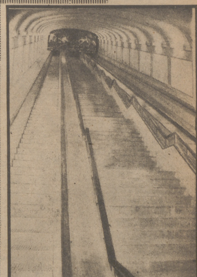
El ministro de Obras Públicas, señor Vigón, acompañado por técnicos de su Departamento, realizó un viaje de inspección a las obras de los nuevos trayectos del Metro madrileño. A la curiosidad de sus próximos usuarios ofrecemos el aspecto que ofrece, ya terminada casi totalmente, la escalera articulada que comunica con la superficie la estación de la plaza de España. Esta escalera automática es la más grande de Europa
