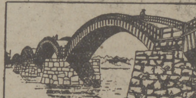
EL GRAN PUENTE DE MADRA DEL CINTURON DEL BOCADO EN IWAKUNI, JAPON. ESTA ARMADO SIN USAR UN SÓLO CLAVO.
