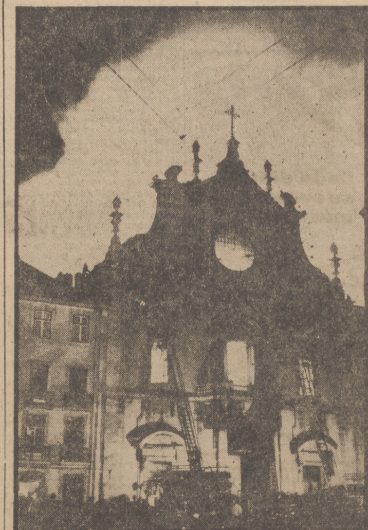
La iglesia de Santo Domingo, de Lisboa, construida en el siglo XVIII en sustitución de otra del XII destruida por un terremoto en el mismo sitio, quedó reducida a escombros a consecuencia de un violento incendio, que ha costado la vida a dos bomberos y heridas de diversa consideración a otras veintitrés personas, especialmente quemaduras sufridas durante los trabajos para extinguir el incendio. El arzobispo de Mytilene, monseñor Dos Santos Rocha, ha calificado el siniestro como una pérdida nacional, por el valor histórico y artístico del templo destruido, con el que han desaparecido magníficas pinturas de Pedro Alexandrino y el sepulcro de fray Luis de Granada.
