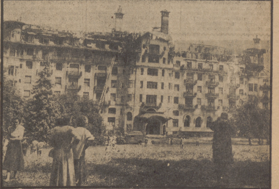
Vio ento incendio en un hotel El hotel Royal, de Evian, uno de los más hermosos de la ciudad, fué pasto de las llamas, que destruyeron gran parte del edificio ocasionando además cuantiosas pérdidas. Unos 280 turistas que estaban alojados en dicho hotel tuvieron que abandonar precipitadamente su tiempo para recoger su equipaje. La fotografía nos muestra el estado en que quedó el hotel una vez que fué sofocado el incendio.—(Foto Keystone-Nemes.)
