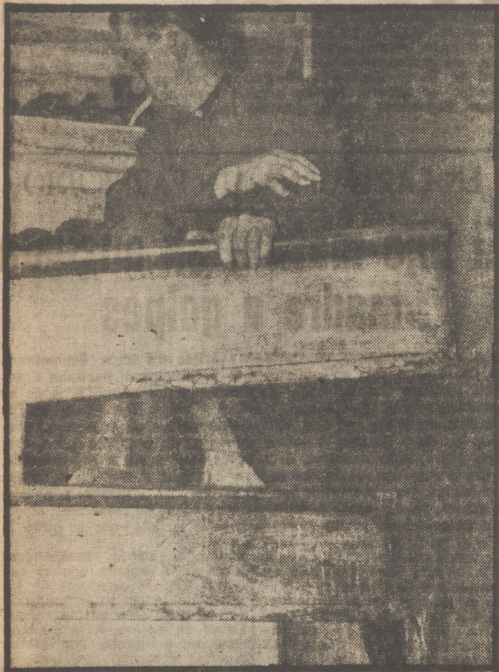
Este es el escondrijo donde se ocultaba Wayne a las pesquisas de la Policía Militar. Bastaba levantar este escalón para que Wayne se deslizase hasta que pasaba la alarma
