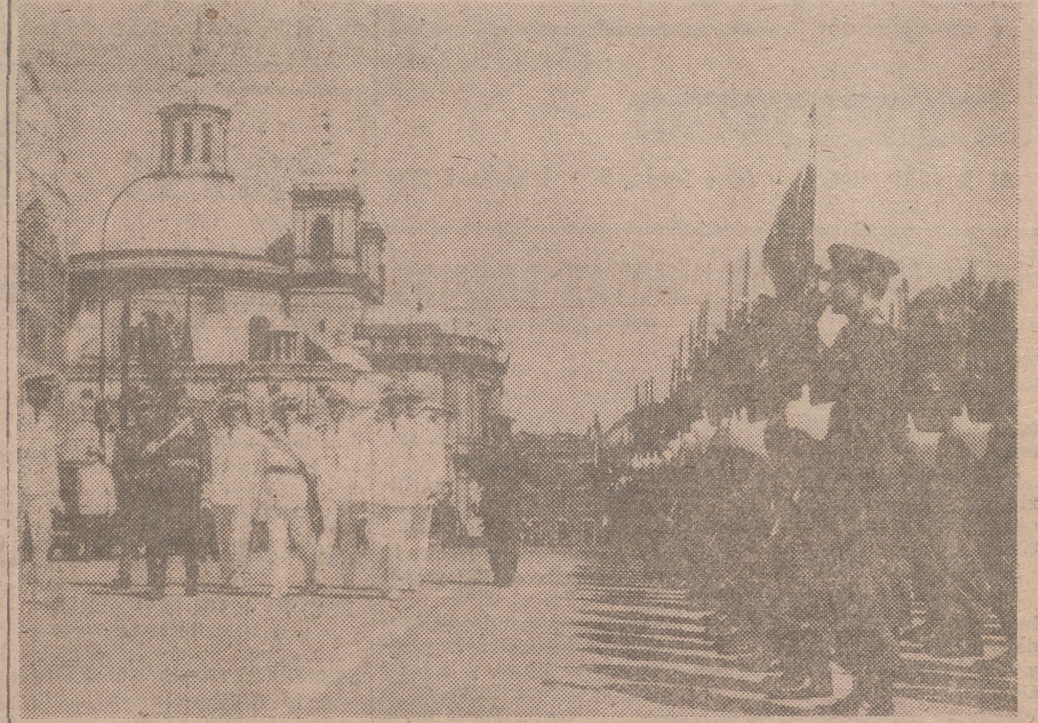
MADRID. — S. E. el Jefe del Estado, Generalísimo Franco, ha inaugurado, en compañía del alcalde de Madrid, conde de Mayalde, y altas jerarquías del Estado, la nueva Gran Vía de los Reyes Católicos, que se inicia en San Francisco el-Grande y llega hasta la Puerta de Toledo y por la que podrán desfilar 3.000 vehículos a la hora. (Foto Europa Press)
