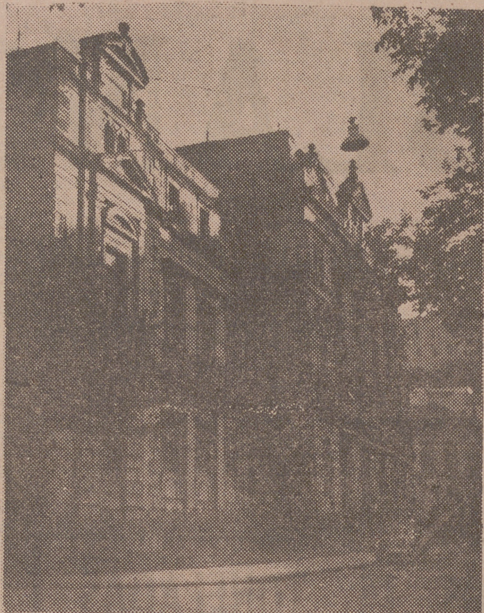
Una vista del edificio donde se instalará la Escuela de Ingenieros Industriales del Estudio General de Navarra en San Sebastián.
