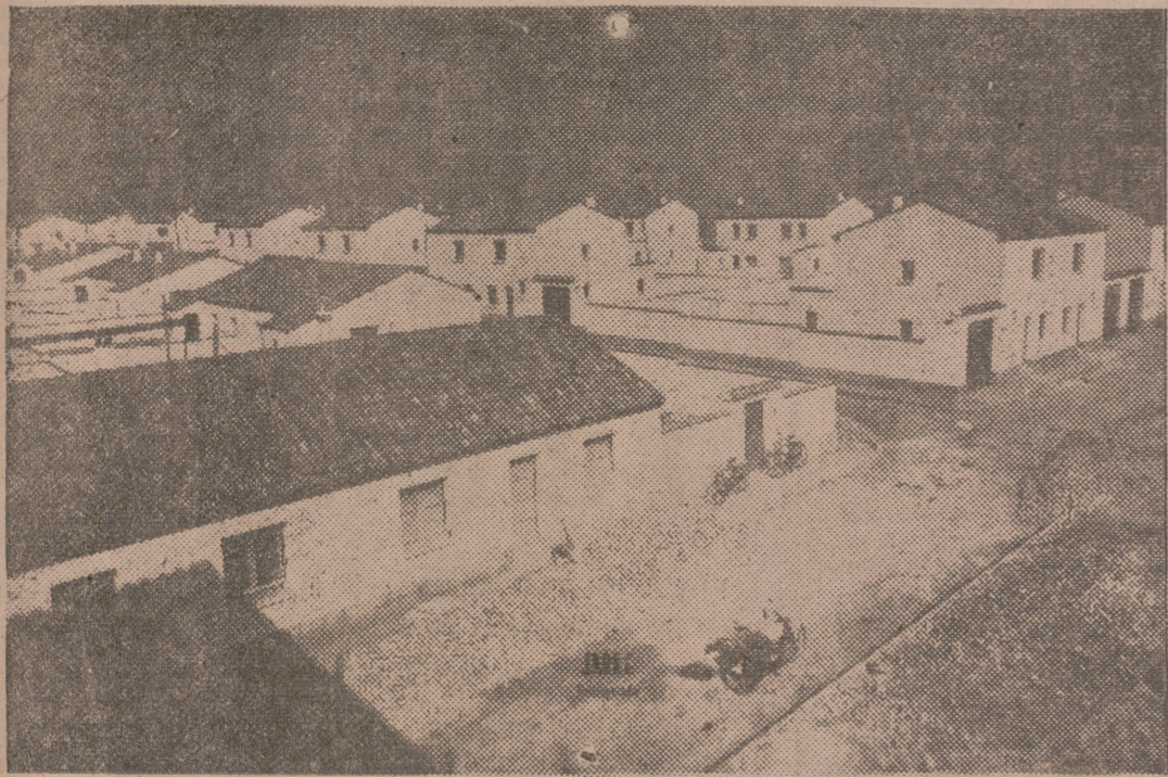
Otro grupo de viviendas construídas por la Caja de Ahorros y Monte de Piedad de Zaragoza, Aragón y Rioja, en Calahorra, con destino a la población rural
