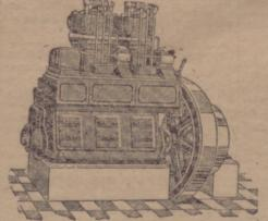
Su puesta en marcha es sen cillísima completamente en fric, sin necesidad de medio auxiliar alguno de ignición, por mani-vela y sin esfuerzo en potencias hasta 28 HP. y por aire comprimido en las mayores.
