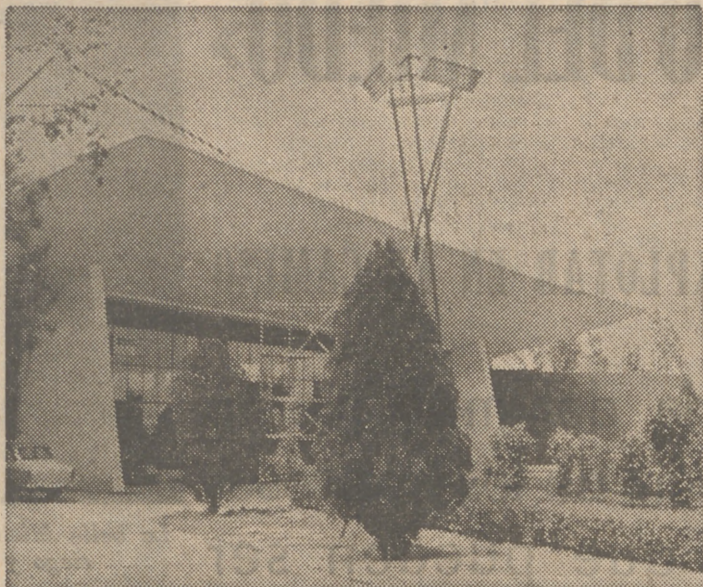
Del 21 de mayo al 21 de junio se celebrará en Madrid la VI Feria Internacional del Campo, en la que se han introducido importantes modificaciones. Las instalaciones están muy avanzadas y pueden apreciarse ya los pabellones en su forma definitiva. Este de la foto corresponde al de Francia, conocido desde la Feria del 63, también remozado para la próxima
