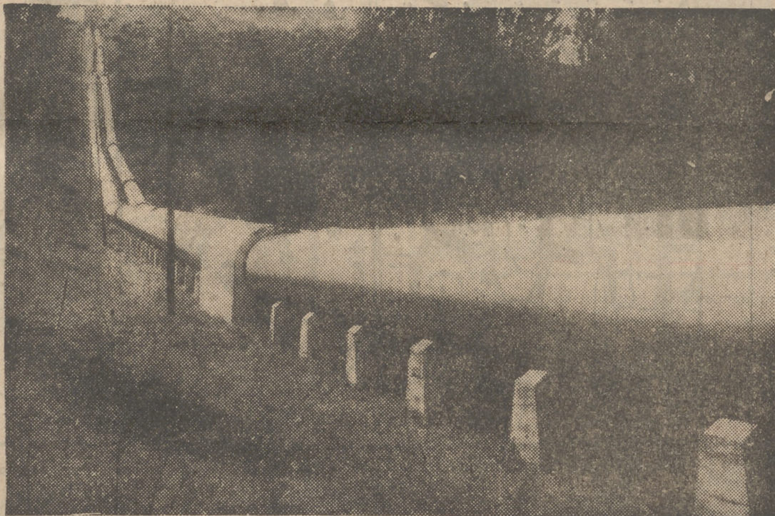
Las obras hidráulicas españolas han sido uno de los grandiosos impactos y conquistas de nuestros veinticinco años de paz. Una de las conducciones de agua en Torrelaguna
