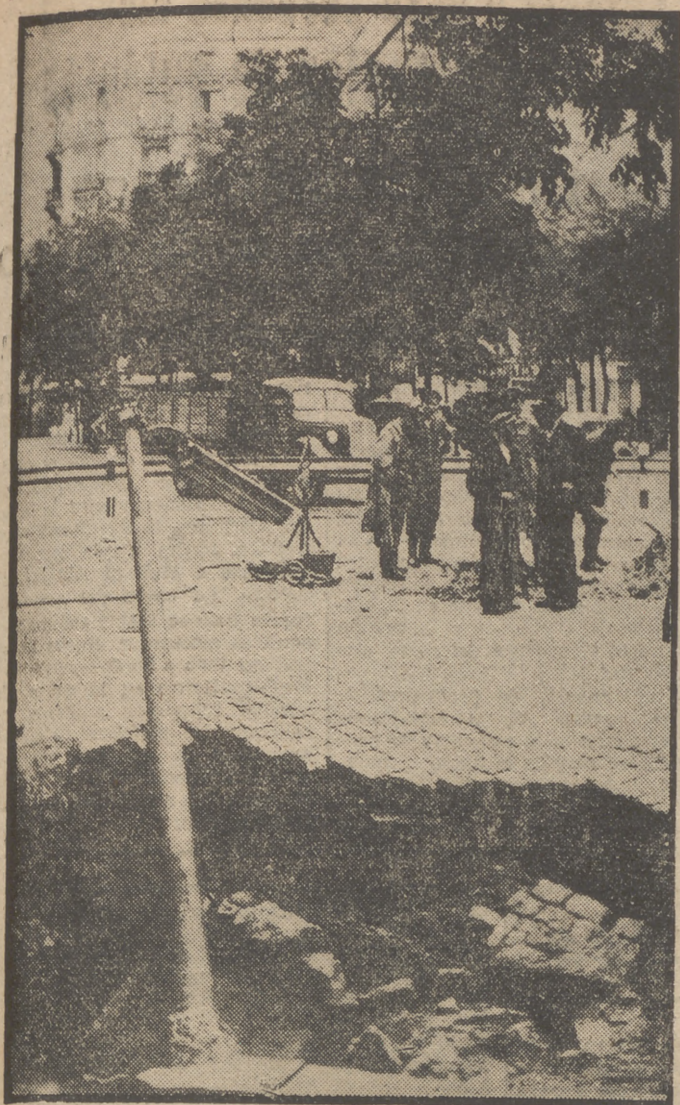
EL SOCAVON DEL DIA.—En la calle de Luchana, en su confluencia con la de Trafalgar, se hundió el pavimento a causa de las infiltraciones de agua. El hundimiento, de grandes proporciones, arrastró una farola del alumbrado público
