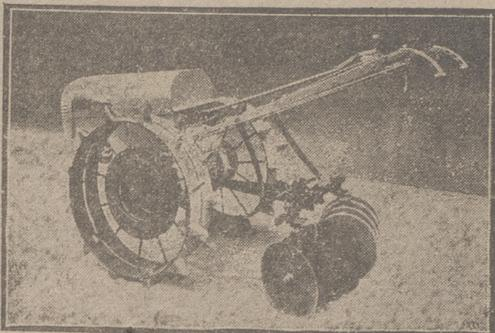
En España ha comenzado la fabricación de tractores y son ya diversas las Empresas que se dedican a la construcción de esta clase de máquinas. Hoy ofrecemos un modelo del tractor nacional marca TRAMSA, de 8 C. V., equipado con grada de discos. Estos tractores están dotados de diversos elementos de trabajo.
