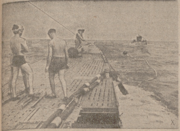
Los sumergibles de ataque alemanes son aprovisionados por otros sumergibles cisternas. La fotografía muestra el momento en que se realiza en alta mar una "transfusión" de esencia.
