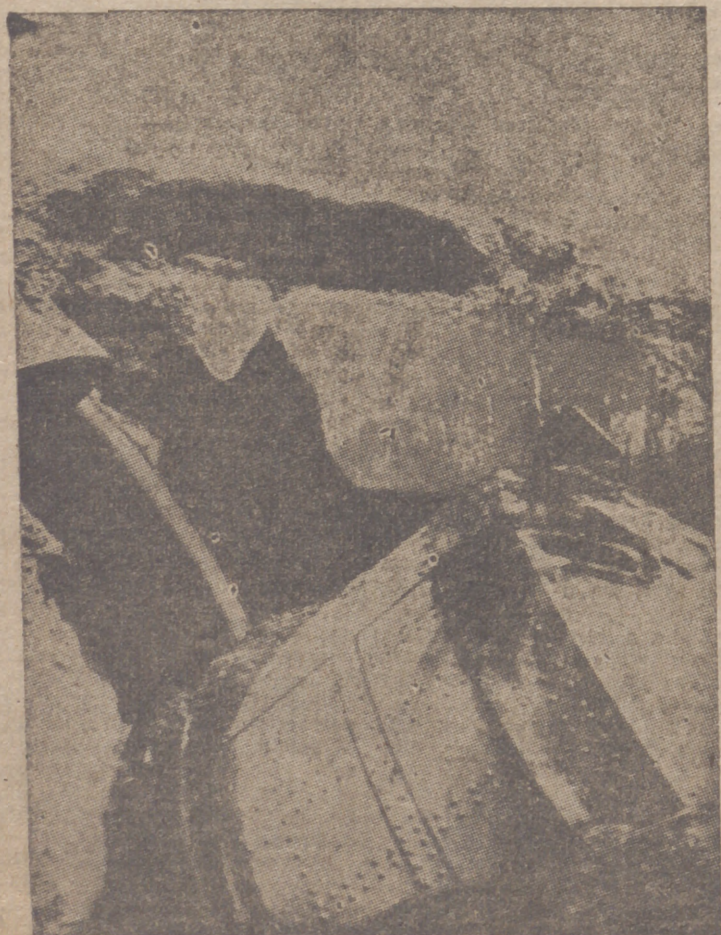
Una cúpula de los famosos fuertes de Lieja que en agosto de 1914 cayeron en manos de los alemanes.—En la fotografía se puede comprobar el efecto de la artillería de grueso calibre.
