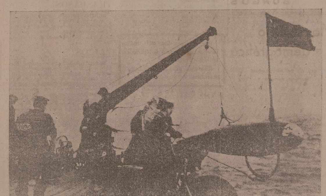
En el mar del Norte dragadores ingleses colocan flotadores que, unidos por un cable y provistos de cortadores, limpian de minas los mares
