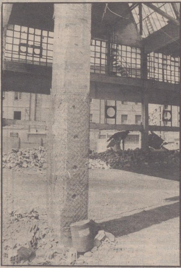
Un pilar con las perforaciones para los barrenos de "goma-2".
