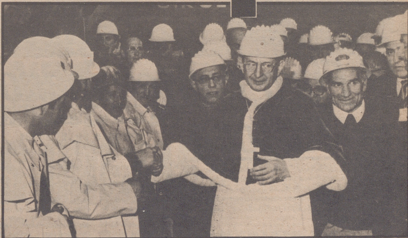
Con casco de obrero bendice a los empleados en las obras de un túnel del ferrocarril.
