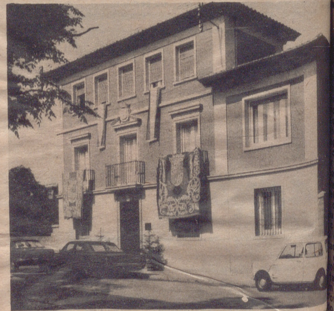
Exterior del edificio en que se sitúa la nueva Escuela de Asistentes Sociales.
