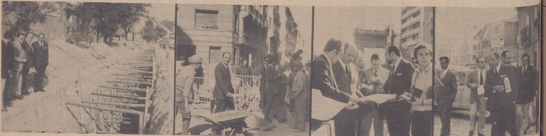
Cuatro aspectos de la visita del alcalde a las obras. El colector de Echegaray, para junio del 73, calle Bolonia, a punto de concluir; Hernán Cortés, terminará en agosto; calle Lorente en plena obra. (Fotos García Luna).
