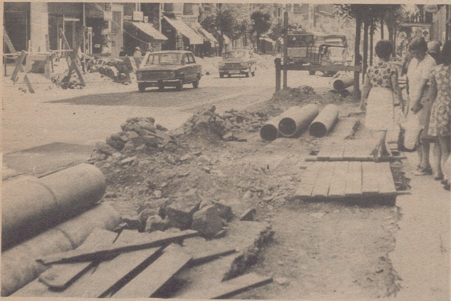
Avenida de Madrid, las obras no durarán mas de dos meses.
