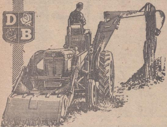
Equipado con PALA CARGADORA FRONTAL de 260 litros de capacidad y PALA RETROEXCAVADORA TRASERA, para una profundidad de trabajo de 3,60 m.
