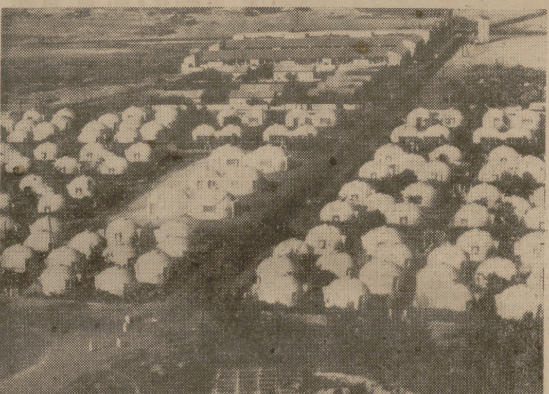
Esto no es una Exposición de escafandras de buzo ni de cascos de minero. Se trata de un proyecto urbanístico hecho realidad por las autoridades francesas de la vivienda en Dakar. Cada "balón" se compone de tres habitaciones y servicios, y sus moradores pueden adquirir la propiedad mediante pequeñas cuotas semanales. En este poblado se albergan alrededor de dos mil personas. El terreno dispone de urbanización perfecta, y cada vivienda está rodeada de un pequeño jardín. El sistema ha obtenido un gran éxito. (Foto Keystone.)
