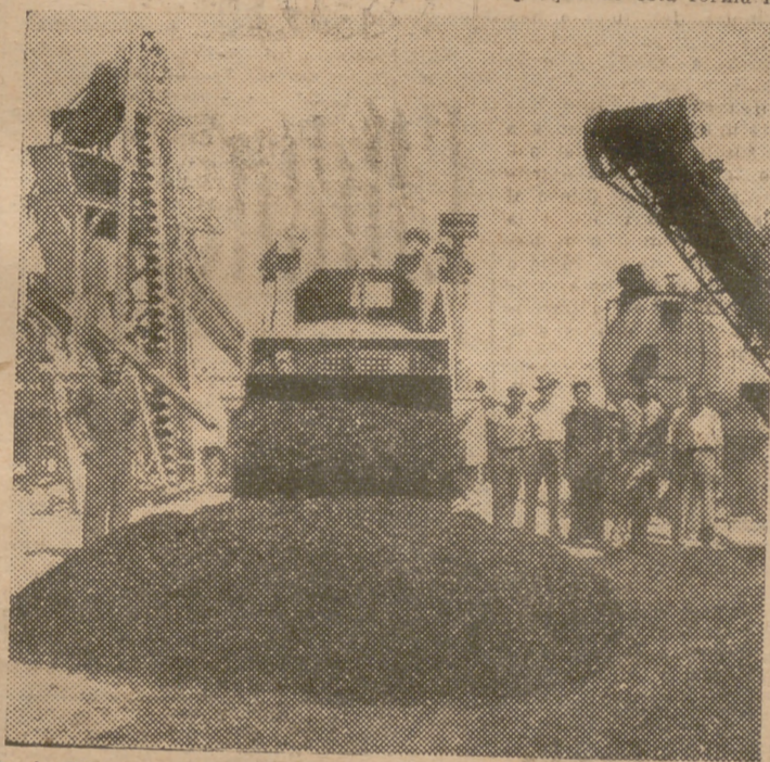
Tres fases de los trabajos de pavimentación de la nueva avenida de Albacete; en la primera, el betún asfáltico es pulverizado sobre la piedra tendida; en la segunda, los camiones de la empresa cargan automáticamente la gravilla mezclada con betún, y en la última, la máquina terminadora la distribuye sobre el suelo, creando una magnífica pista.
