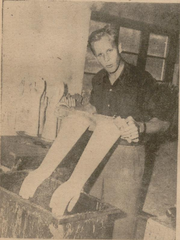
En estos moldes se introduce el líquido de goma del que luego saldrá un traje capaz de resistir las más bajas temperaturas del agua.
