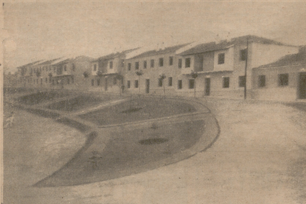
Este es un aspecto de las nuevas viviendas entregadas por el ministro de la Gobernación a los habitantes del "Barrio sin Permiso", que en la madrugada de hoy ha sido demolido por una brigada de obreros, con lo que queda solucionado el régimen de habitación que gravitaba sobre estas gentes. Este es un aspecto del citado barrio, compuesto por 686 chabolas, que, gracias a la labor del Gobierno, ha dejado de existir.
