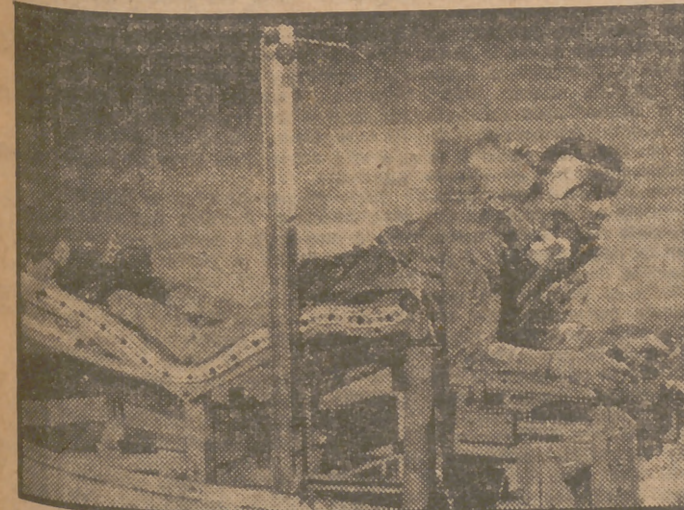
Esta "cama" para los pilotos empieza a emplearse para entrenamientos de los aviadores norteamericanos que han de volar en los "planos" del futuro. Esta posición permite al escueto aparato volador la estabilidad, a la vez que aprovecha todas las posibilidades para accionar los mandos.
