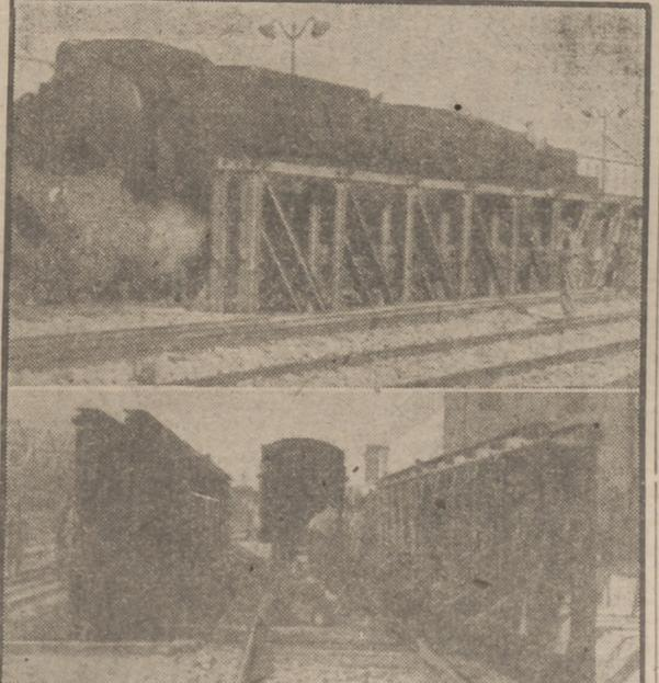
En la primera foto, una locomotora de 248 toneladas pasa el puente desmontable que ha sido construido con arreglo al proyecto del coronel Grande. En la segunda, una vista del citado puente durante su montaje. (Información en última página.)
