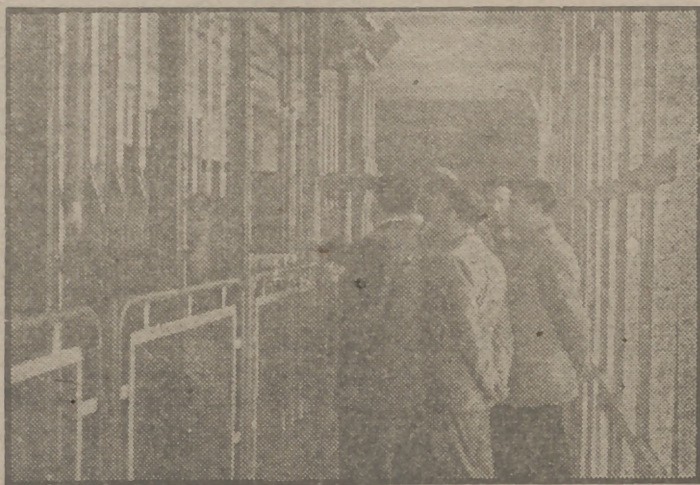
El Consejo Económico Sindical, en su reciente visita a la central térmica de Ponferrada, fué informado con todo detalle de las últimas particularidades técnicas de la instalación. He aquí un momento de su paso por la sala de conexiones de alta tensión.
