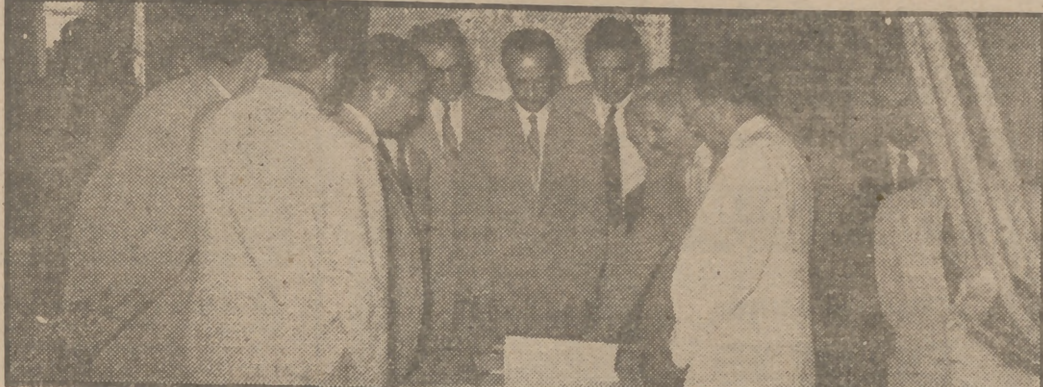
El Delegado Nacional de Sindicatos visita el edificio en construcción donde se instalará la Escuela Sindical Central de Formación Profesional Nuestra Señora de la Merced.
