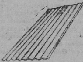
Bovedillas patentadas para la construcción de techos.
