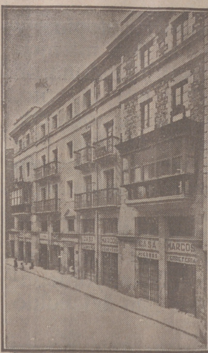
Fachada, por la calle de la Moneda, números 15 y 17, de la CASA SOCIAL propiedad de la Federación Burgalesa de Sindicatos Agrícolas Católicos.
