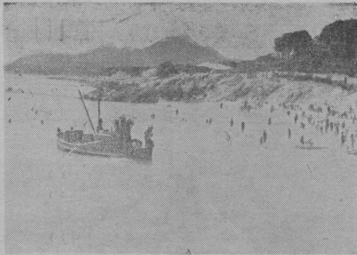
Construcción de emisarios en la playa de «Son Moll» (Foto Margarita)
