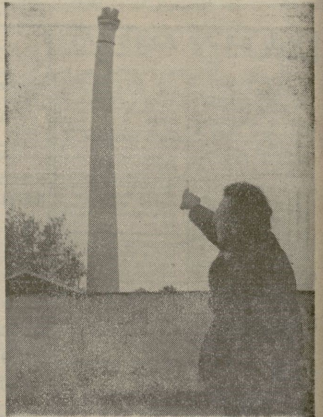
LA CHIMENEA DEL PORTITXOL, UNA DE LAS QUE CONSTITUYEN MAS SERIA AMENAZA. OBSERVESE SU GRADO DE INCLINACION. ESTA GRAVE, NO CABE DUDA.
