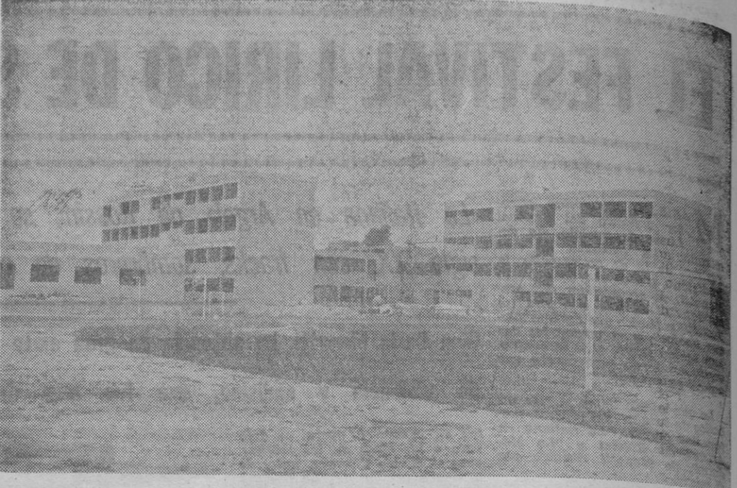
Estado actual de las obras del «Instituto Nacional Mixto de Enseñanza Media». (Foto Payeras - Inca).
