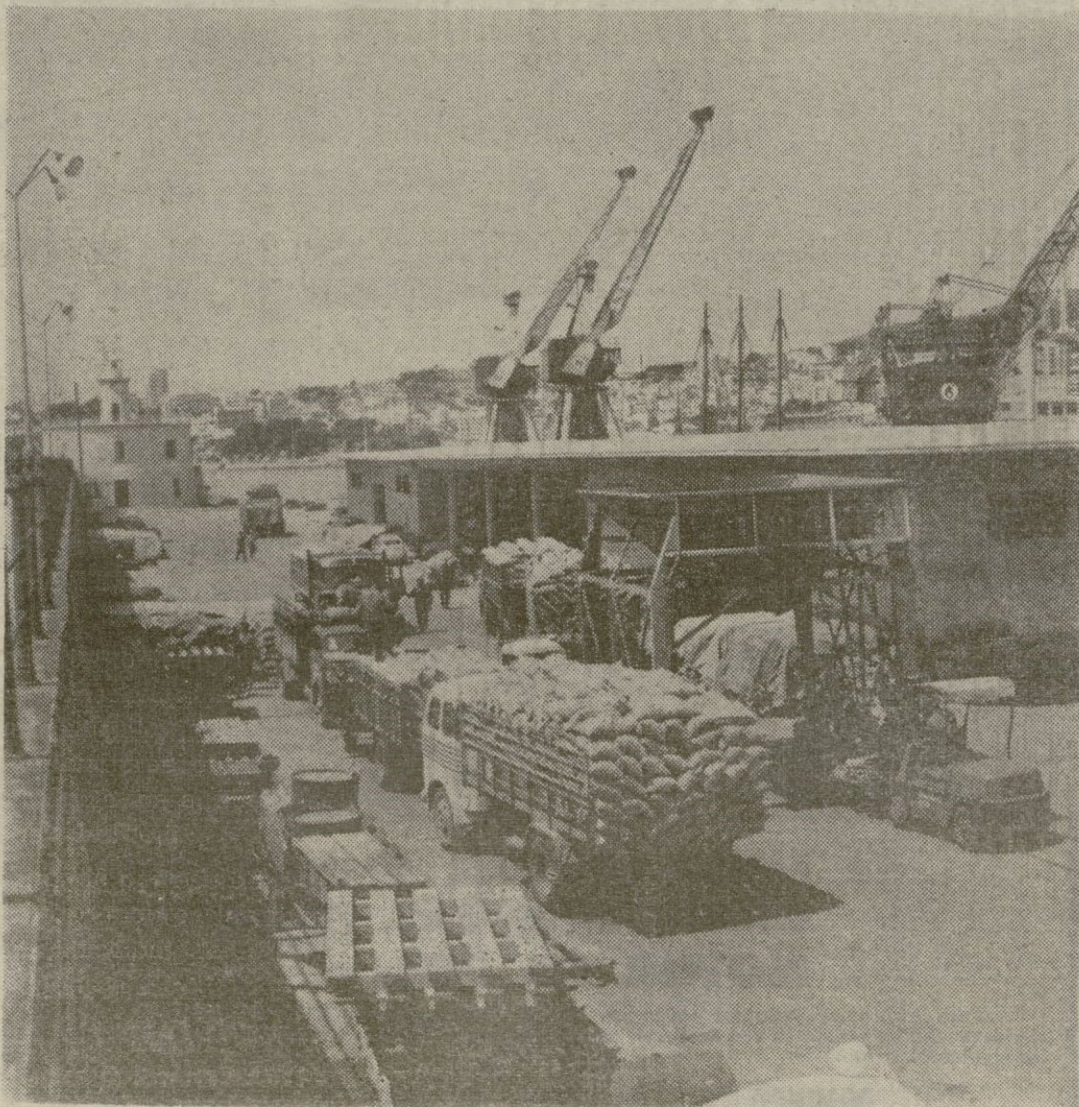
MALLORCA, EN ALGUNAS EPOCAS DEL AÑO, EXPORTA MUCHO. ESPECIALMENTE, PATATA. ESTA ES LA MERCANCIA QUE TRANSPORTAN ESTOS CAMIONES. AL FONDO, TRES GIGANTESAS GRUAS QUE PERMITE LA CARGA Y DESCARGA CON RAPIDEZ. ESTO, AHORA ES EL MUELLE COMERCIAL, PORQUE LOS BUQUES CORREOS AMARRAN EN PÉLAIRES.
