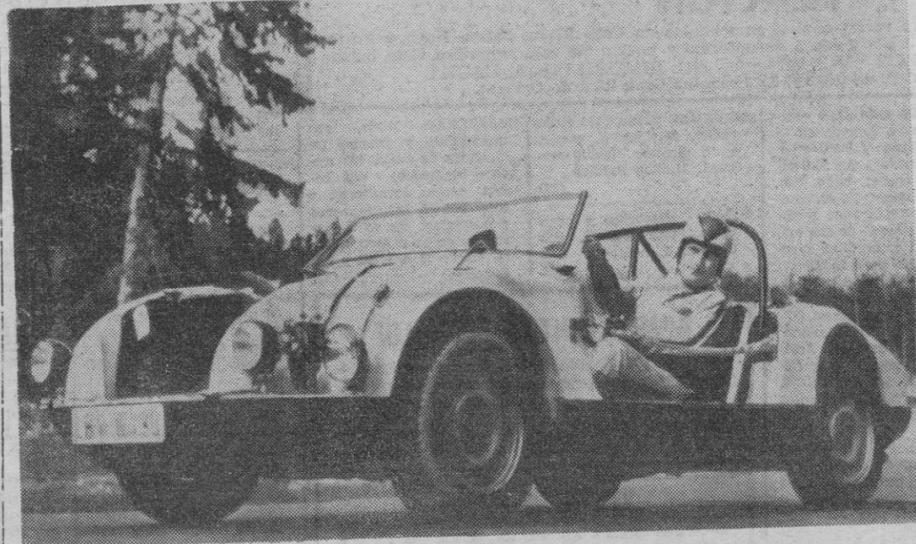
EL RECORRIDO-PRUEBA DEL AUTOMOVIL DE PLASTICO SE REALIZO EN EL CIRCUITO DE NURBURGRING. EL CHASIS DE PLASTICO HA RESULTADO MUY EFICAZ. LLEVA ACOPLADO UN MOTOR DE 2.000 C.C., SUSPENSION Y TRANSMISION «BMW». — (Foto Cifra)
