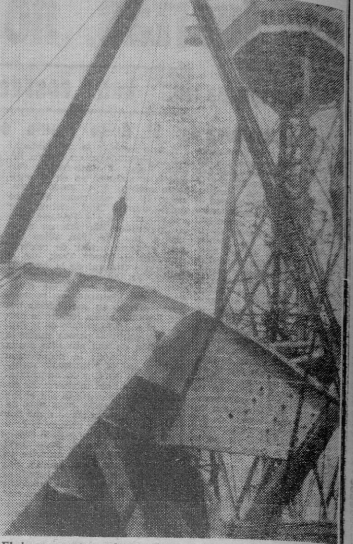
El buque norteamericano «Biddford Victory» ha llegado al puerto de Barcelona con la gran antena que se instalará en Robledo de Chavela, a sesenta kilómetros de Madrid, para el control de satélites tripulados.
