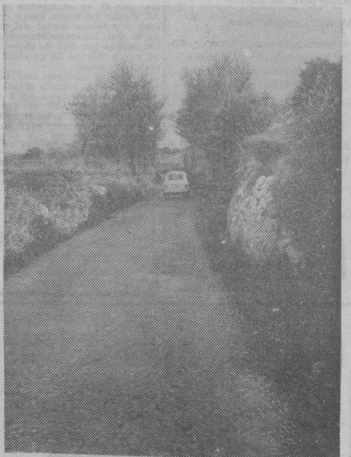
NO PUEDE CONTINUAR POR MAS TIEMPO LA ESTRECHEZ DE LA CALZADA DE LA CARRETERA QUE VA DE PETRA A LA GENERAL DE PALMA - MANACOR. LOS TRES METROS SON INSUFICIENTES PARA QUE PASEN DOS VEHICULOS. FIJENSE EN EL "RENAULT 4/L" DE "BALEARES" —VEHICULO DE DIMENSIONES NORMALES— QUE OCUPA CASI LA TOTALIDAD DE LA CARRETERA. AQUI SE REPRODUCEN LOS EMBOTELLAMIENTOS. CUATRO KILOMETROS QUE EXIGEN UNA OBRA DE VITAL NECESIDAD
