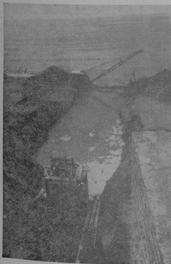
Obras Hotel Don Pepe (Málaga)
