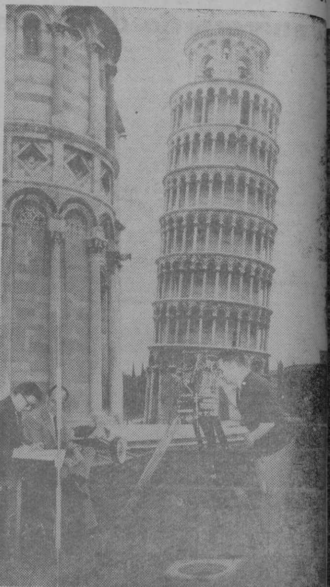
LOS TECNICOS EFECTUAN EL «RITO» ANUAL DE LA MEDICION DEL INDICE DE DESVIACION DE LA TORRE DE PISA.
