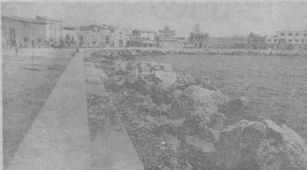
LA CONSTRUCCION DE ESTE MURO REPRESENTA UNA IMPORTANTE MEJORA PARA EL MOLINAR. ASI, SE ELIMINA EL PELIGRO DE INUNDACIONES DEBIDO A LA FURIA DEL MAR. SI SE CONSTRUYE AHORA UN PASEO MARITIMO, ESTA ZONA SE VERA MEJORADA AL MAXIMO. — (Foto «Juanet»)
